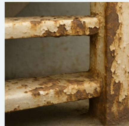
錆の腐食は毎年0.1mm進むと言われていますが、沿岸地域では2~3倍の速さで進行します。
